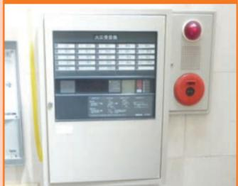
感知器が火災を感知したとき、又は発信機の押しボタンが押されたときに火災の発生場所を表示します。同時に音響装置（ベルなど）を連動させ、建物内にいる人々に火災を伝えるものです。
