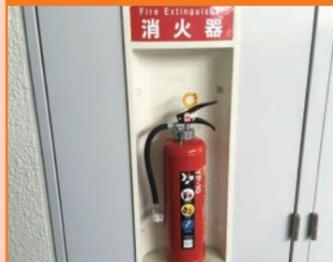
消火器は、火災の初期消火に最も効果的な消火用具です。建物内の各階ごとに設置されており、歩行距離が20m以下の場所に置いてあります。消火器の放射時間は通常の粉末消火器で約15秒です。いざ使用する時には、他の人と声を掛け合って他の場所から持ってきて、2本、3本で消火するのが効果的です。
