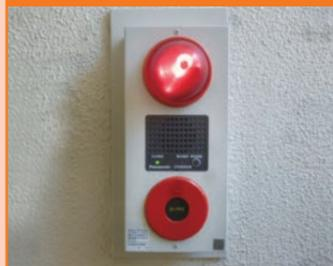
火災発生を建物内外の人たちに知らせるため、発信機（押しボタン）を押し込むことによりベルをならす音響装置です。
