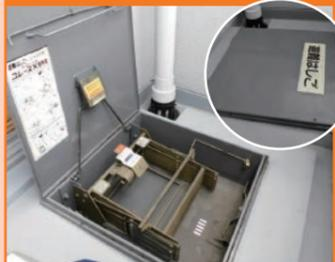
写真は、金属製避難はしごを避難器具用ハッチに収納したタイプのもので、通常は、ハッチを閉めてありますので、いつでもすぐ使用出来るように、ハッチの上や下に物がなく、また、ハッチやはしごが錆びていないかを確認します。
