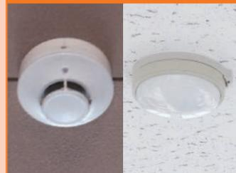
火災の際、発生する熱や煙を感知するもので、天井部分に設置されています。
